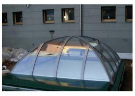
Questo sistema di copertura, può essere scelto sia perché la misura è troppo grande per poter utilizzare le cupole termoformate classiche sia perché è un sistema esteticamente piacevole e in ambienti dove si vuole oltre alla luce arredare i locali il sistema è indicato.
